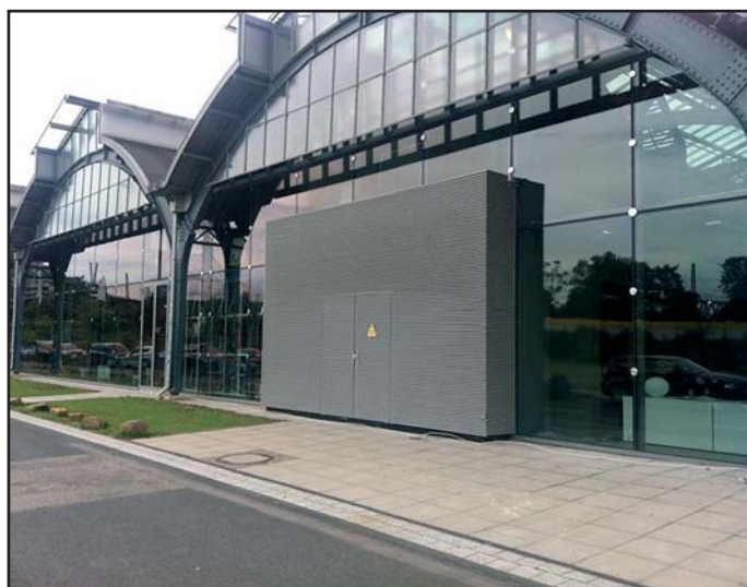
MLL-HAMBURG fertigt begehbare Einhausungen für E-Räume der Schutzklasse IP23D.
